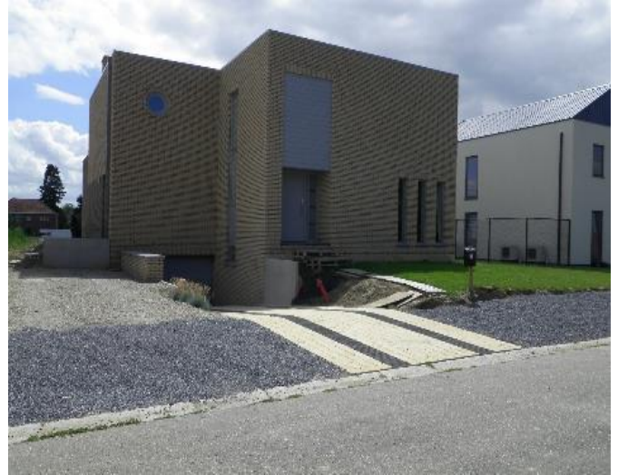
Foto 3 : (half)ondergrondse garage met afhellende inrit vanaf straat met drempel = voorbeeld van hoe het wel moet/kan.
