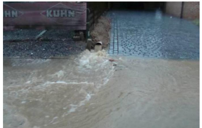
Foto 11 : leegloopbuis aan de straatkant (in werking)
