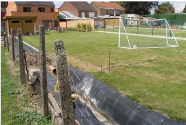
Foto 10 : afleidingsgracht in tuin (deels open, deels ingebuisd)
