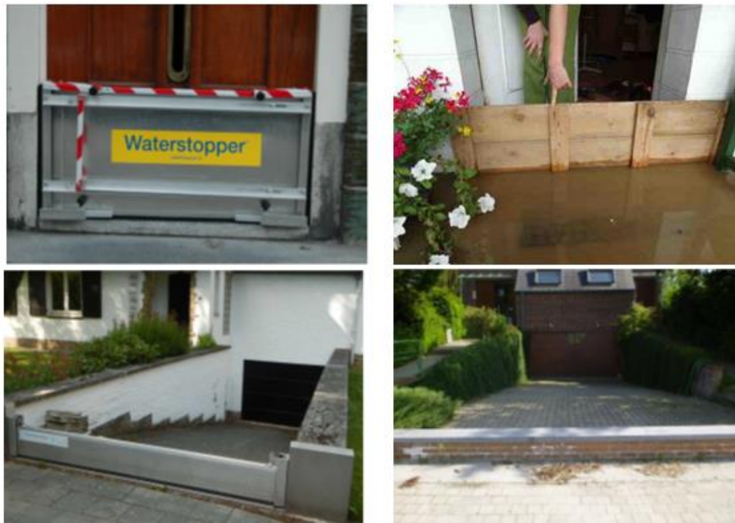
Figuur 4 : voorbeelden van (tijdelijke en permanente) afdichtingen
