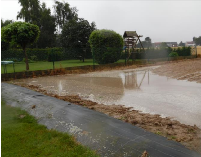
Foto 8 : aarden wal/dam achteraan tuin
