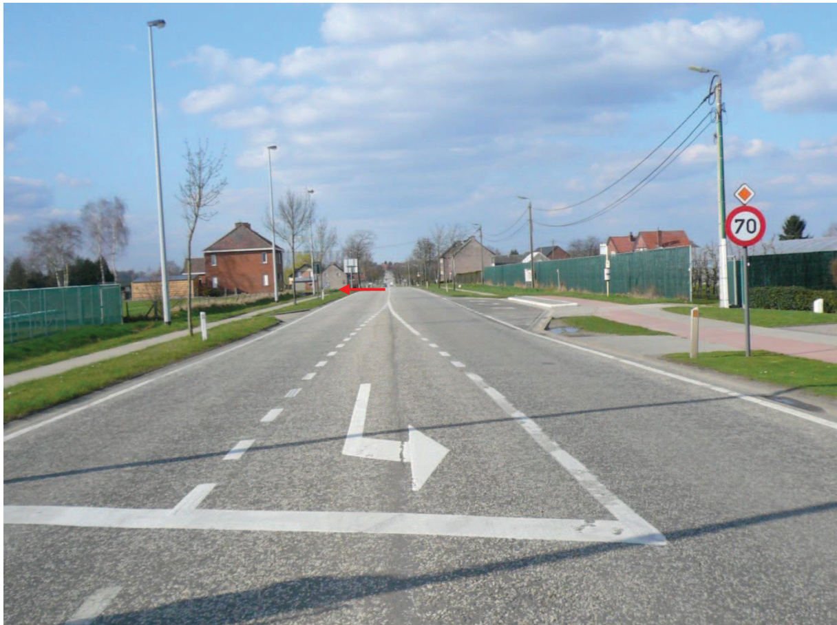
Figuur: Grote Steenweg (N716), vanop het kruispunt met de Kraaistraat richting Herk-de-Stad. Geplande ontsluiting t.h.v. de rode pijl (voorbij de woning) (eigen fotomateriaal).
