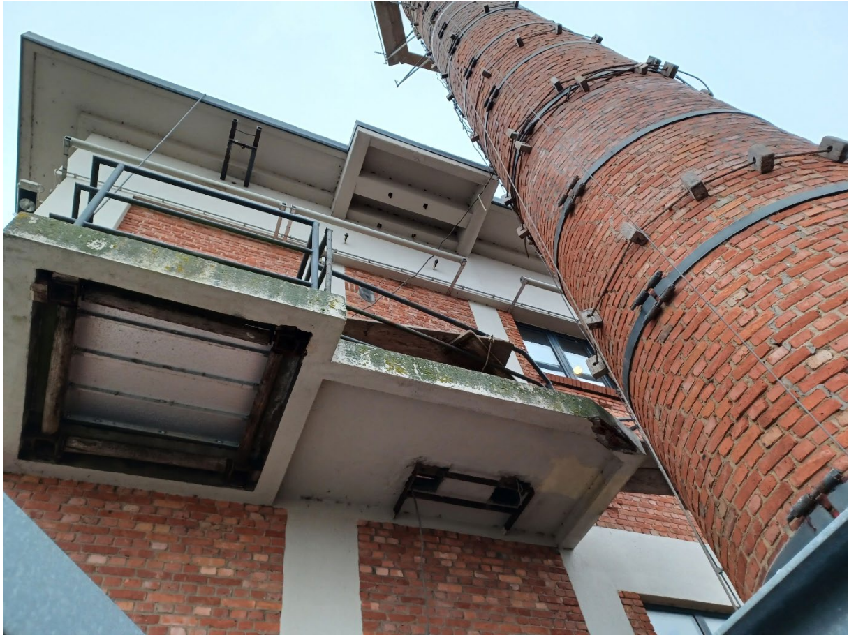
Figuur 46: Renovatie schouw Mena in Rotselaar
