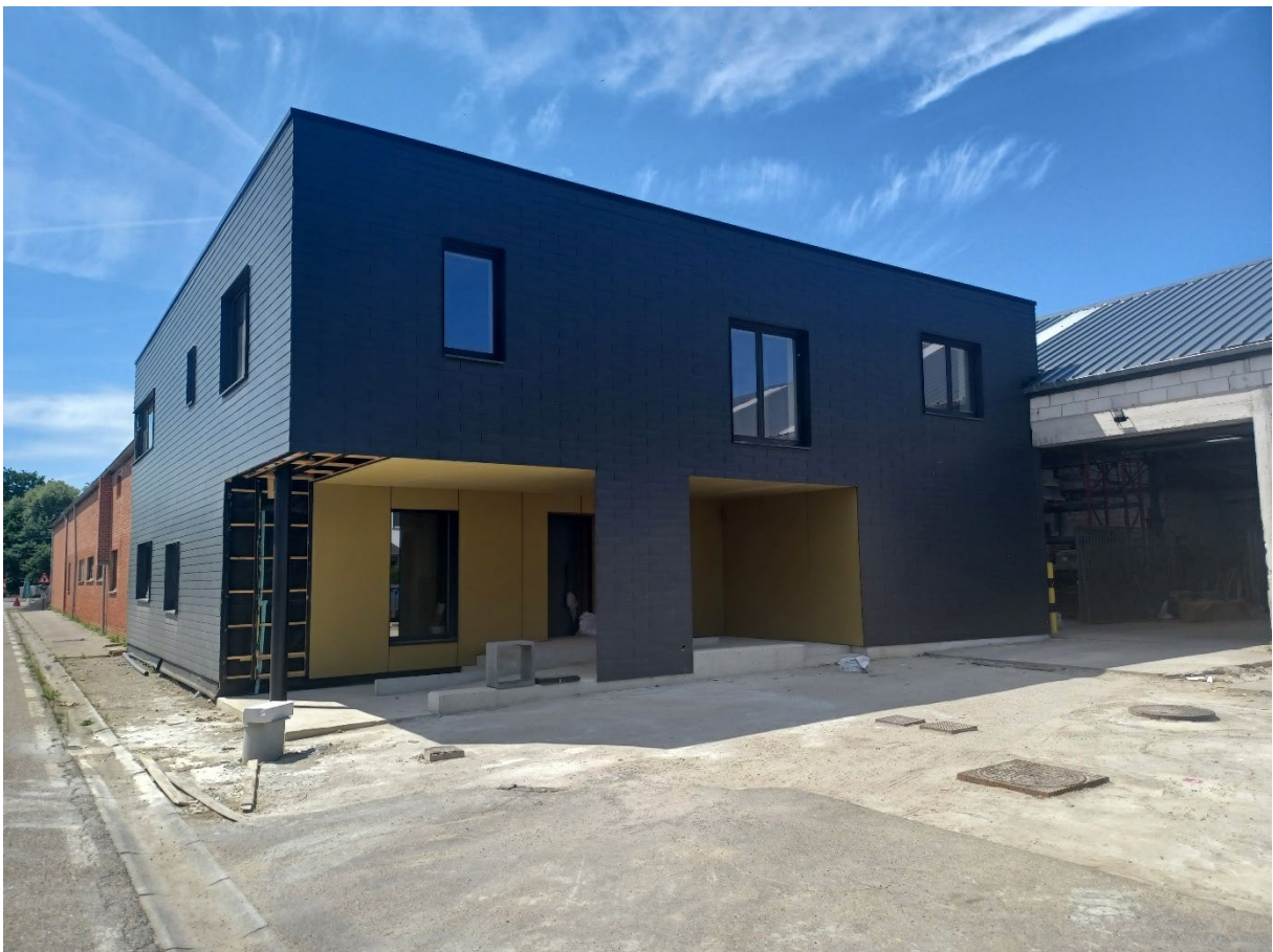
Figuur 45: Verbouwing gemeenteloods in Tremelo
