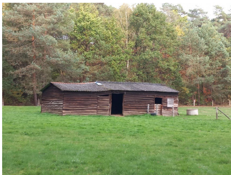
Figuur 12: Asbestdak
